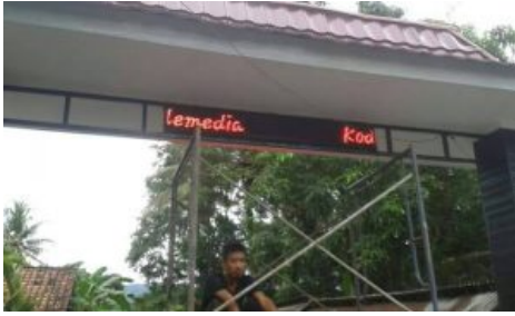
Gambar 12. Pemasangan Running Text
