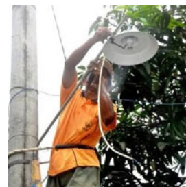
Gambar 10. Pemasangan Lampu Jalan
